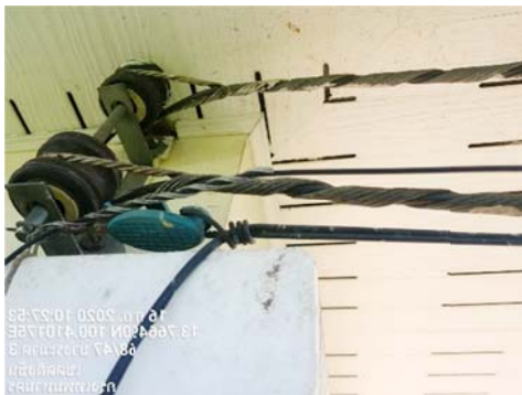
ภาพประกอบที่ 4.17 ติดตั้งสาย New Access OFC ภายในอาคาร
