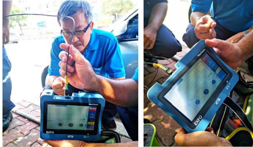
ภาพประกอบที่ 4.18 บริการ FTTx ที่ใช้สาย New Access OFC ค่า Loss ได้ตามมาตรฐาน
