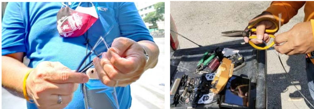
ภาพประกอบที่ 4.5 พนักงานติดตั้งบริการ FTTx ทดลองปกกสาย New Access OFC
