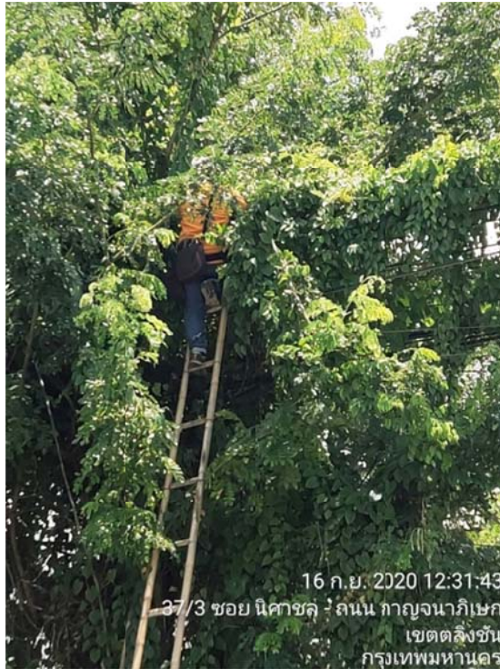
ภาพประกอบที่ 4.16 ติดตั้งสาย New Access OFC พื้นที่กระรอกชุกชุมทดลองการป้องกันสัตว์กัดแทะ
