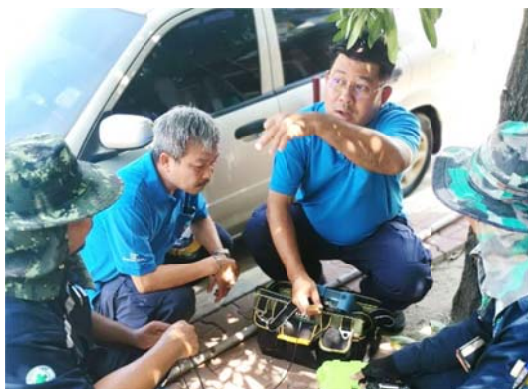
ภาพประกอบที่ 4.7 พื้นที่ บน.2.1 ทดลองเชื่อมต่อสาย New Access OFC ด้วยเครื่อง Fusion Splicer กับสายที่ใช้ในโครงข่าย ODN
