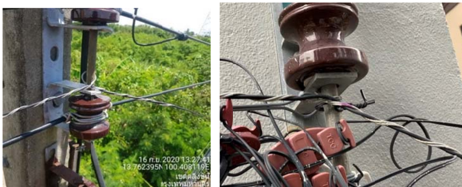
ภาพประกอบที่ 4.15 สาย New Access OFC ที่จับยึดด้วย Tangent
