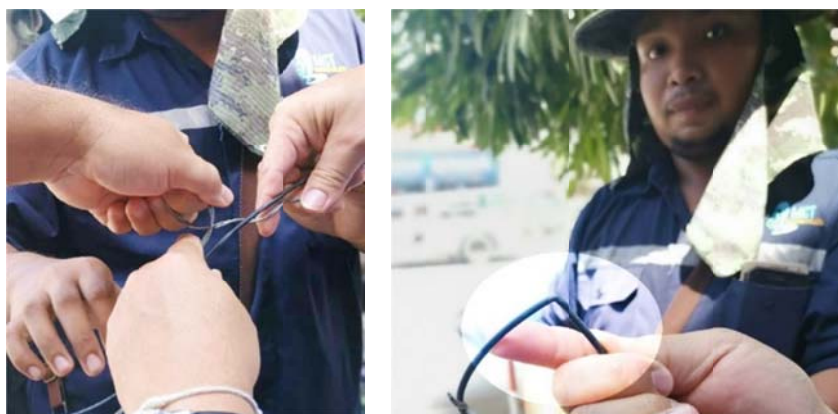
ภาพประกอบที่ 4.14 สาย New Access OFC ที่จับยึดด้วย Tangent โค้งงอเปลี่ยนรูป
