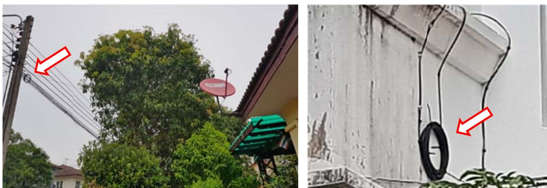
ภาพประกอบที่ 3.3 ตำแหน่ง Loop สาย New Access OFC ก่อนเข้าอาคารหรือตำแหน่งเสาไฟฟ้า
