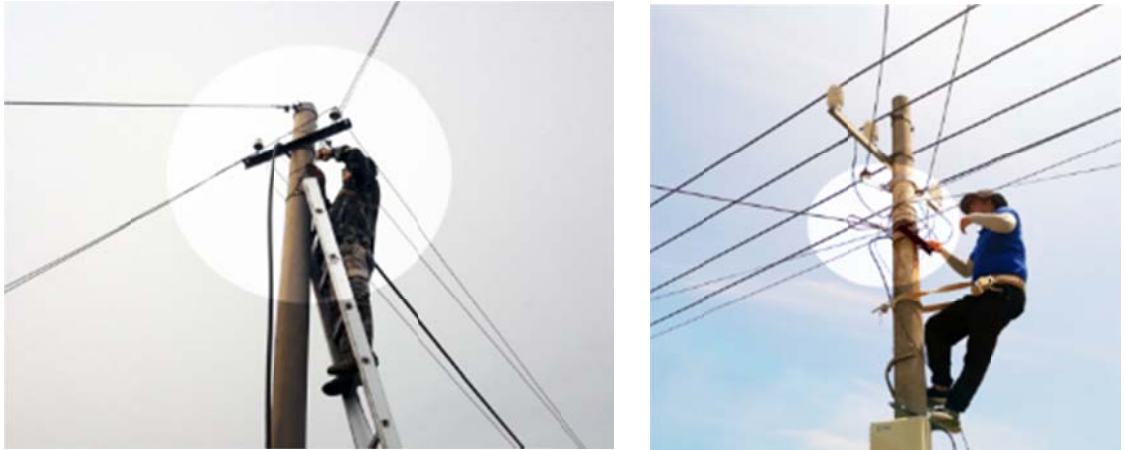
ภาพประกอบที่ 2.39 วิธีการติดตั้งสาย Access OFC ที่มีสายสะพานรับแรงดึง
