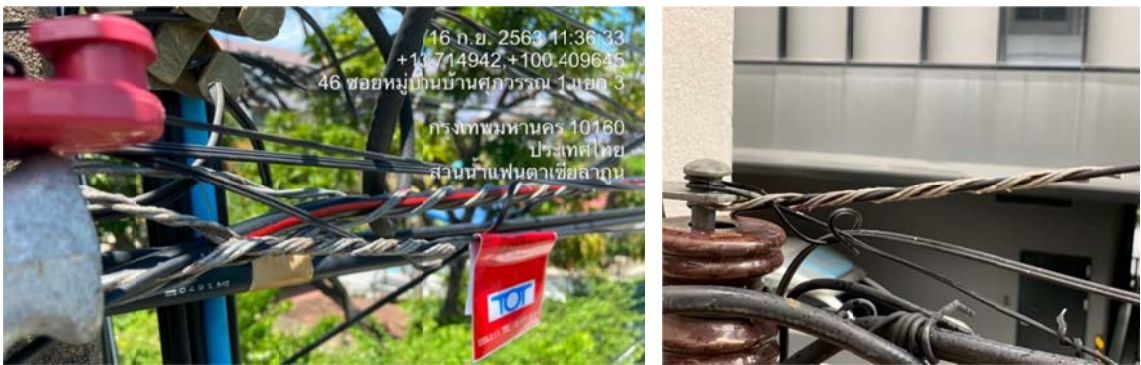
ภาพประกอบที่ 4.12 ติดตั้งอุปกรณ์จับยึด Deadends รับแรงดึงด้านเดียว
