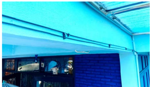
ภาพประกอบที่ 4.17 ติดตั้งสาย New Access OFC ภายในอาคาร
