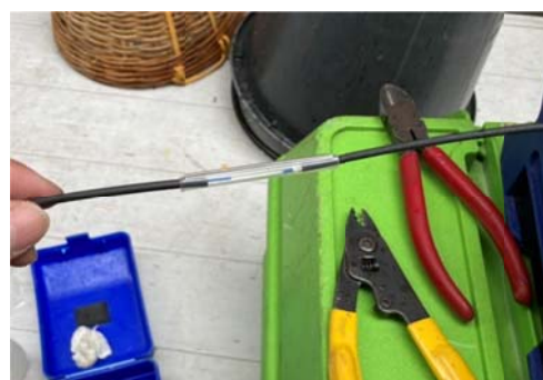
ภาพประกอบที่ 4.8 พื้นที่ บน.1.2 ทดลองเชื่อมต่อสาย New Access OFC ด้วยเครื่อง Fusion Splicer กับสายที่ใช้ในโครงข่าย ODN
