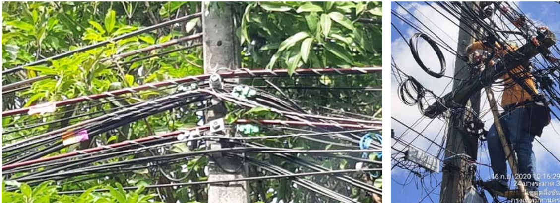
ภาพประกอบที่ 4.10 สภาพสายสื่อสารที่ติดตั้งกับเสาไฟฟ้าของ กฟน.
