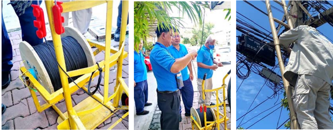
ภาพประกอบที่ 4.9 พาดวางสาย New Access OFC ด้วยเครื่องคลี่สาย
